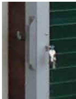
Mit Profilzylinder und geneigten Griffen, sowie innenliegendem Bedienhebel für Schiebetore.
