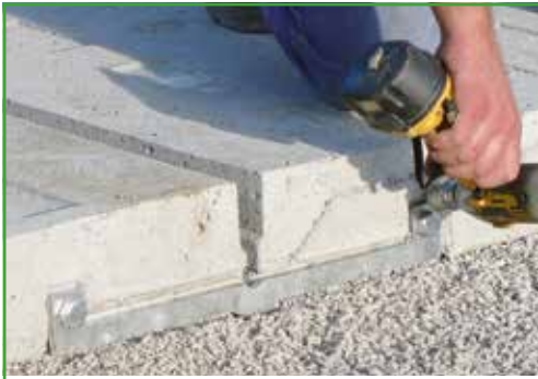
Die einzelnen Fertigelemente werden miteinander verschraubt.
