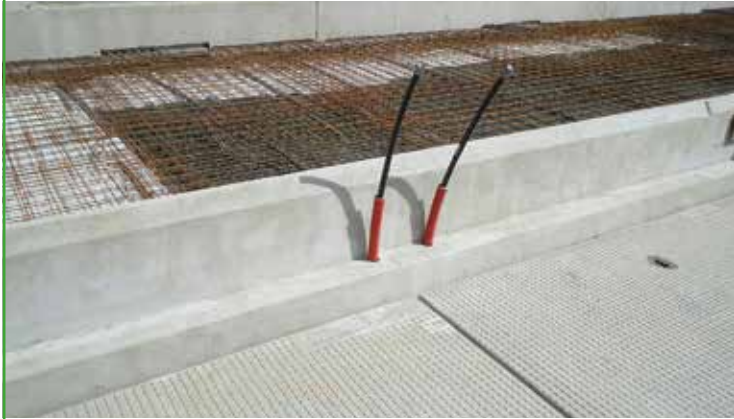
Die Trogwand-Fertigelemente werden mit den MaxiGrip -Fertigelementen verschraubt. Die Anschluss-Eisen werden an die Betonstahl-Bewehrung der Durchfahrt angebunden, wodurch der Futtertisch in kürzester Zeit fertiggestellt werden kann.
